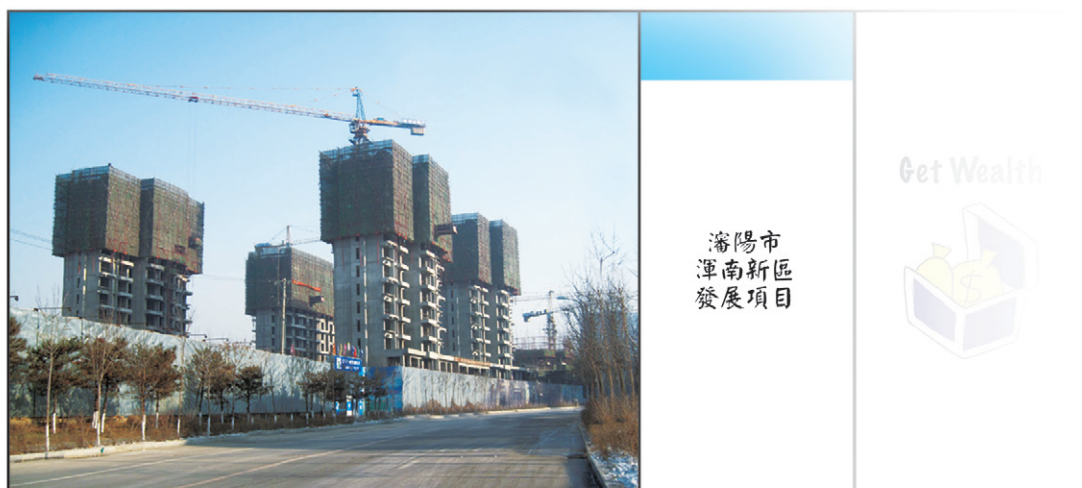
建築工程進行中
